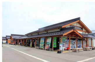
道の駅 南魚沼「雪あかり」
