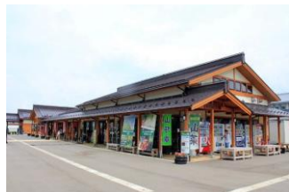
道の駅 南魚沼「雪あかり」
